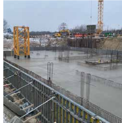
Bundpladen til det 15 etagers kontorhøjhus, WTC Ballerup, blev støbt i ét stræk på 22 timer. I alt blev der til den 2.235m² store bundplade brugt 5.300 tons beton
